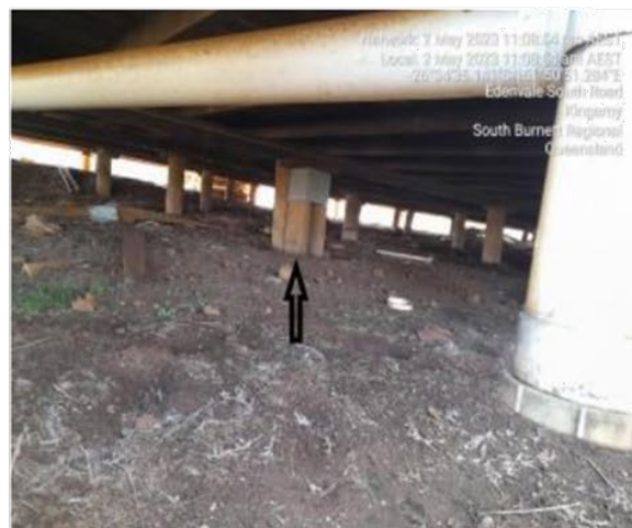
Concrete block in lieu stump.
